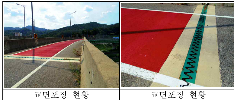
【그림 3.3】 교면포장 현황
