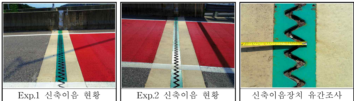
【그림 3.20】 신축이음장치 현황 및 외관조사
