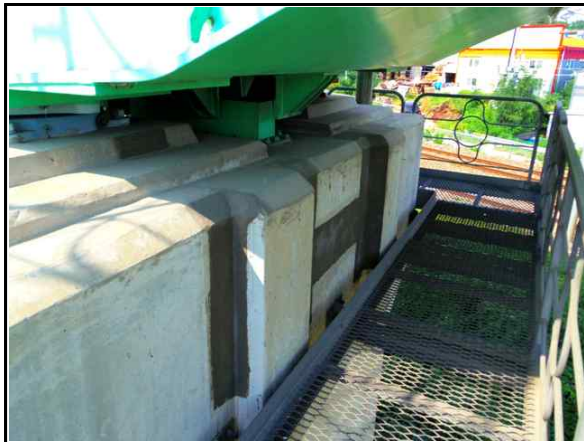
교각 코핑부 균열 보수 전경(P2)
