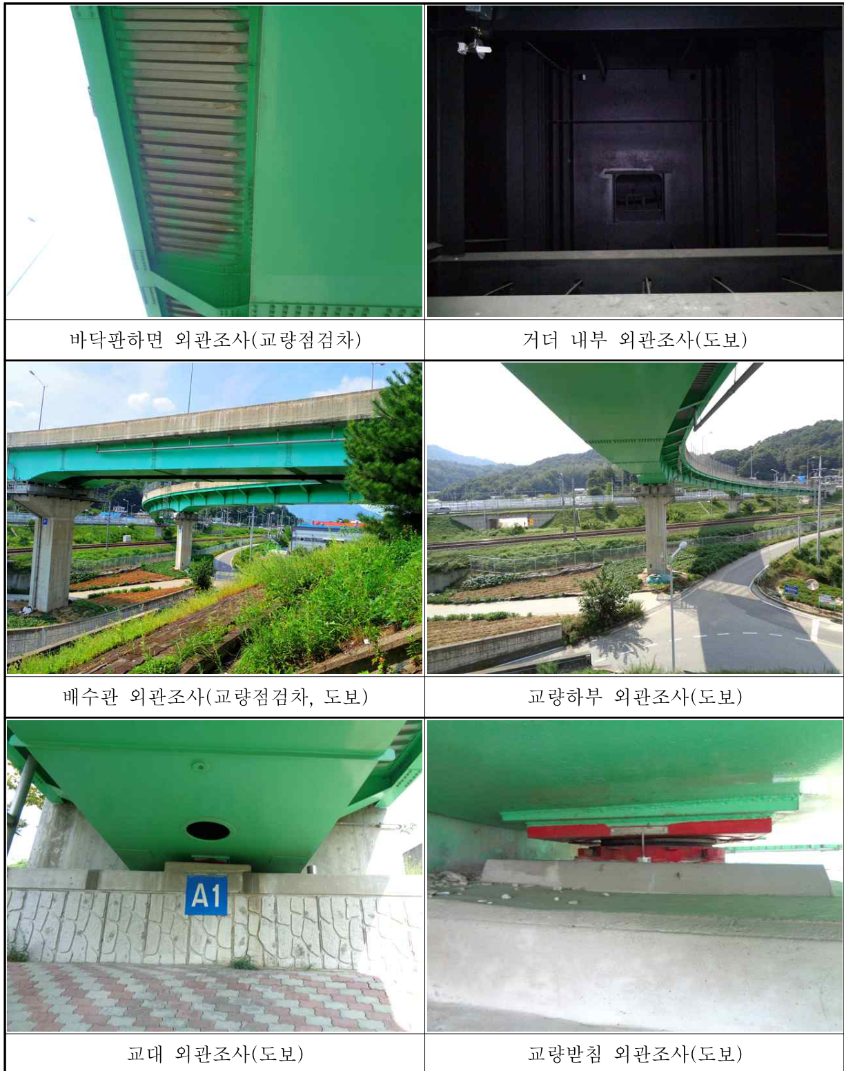
【그림 3.2】 외관조사 전경
