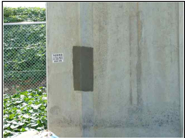
교각 기둥부 파손 보수 전경(P1)
